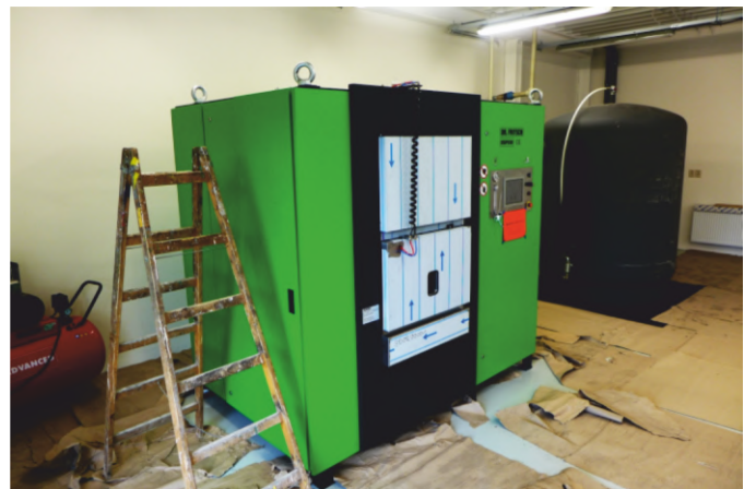
Inštalácia lisu nie je žart. V zadnej časti vodný rezervoár 4 000 litrov na chladenie lisu.
